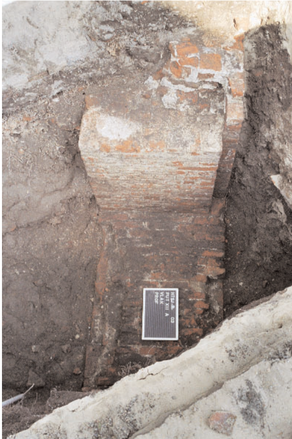
Afb.21 Put XII.A: bovenaanzicht van de dichtzetting van de hoektoren met drempel (F2).
