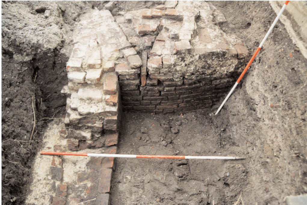
Afb.9 Put XIX: dichtzetting van een schietgat (F24) in de noordkant van de toren in het Sint-Jansbolwerk – richting Z.
